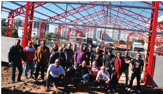
Diretoria do Sindicato visitando às obras do ginásio Foto: Luiza Alves
